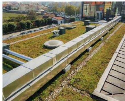
O sistema de cobertura ajardinada extensiva "Urbanscape" combina o peso mínimo [**69kg/m<sup>2</sup>** de peso saturado] sobre a estrutura com uma vegetação de **baixa manutenção** e custo, aliado a maior durabilidade face aos telhados e coberturas tradicionais.
